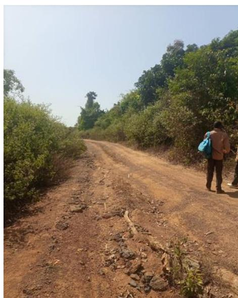
**Figure 22** : voie reprofilée avec des blocs de scories
