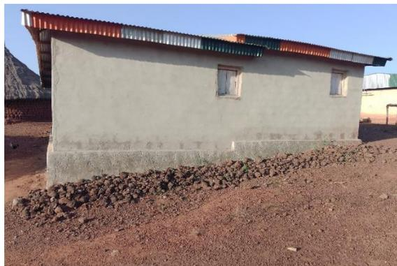
**Figure 20** : scories utilisées pour remblais autour
